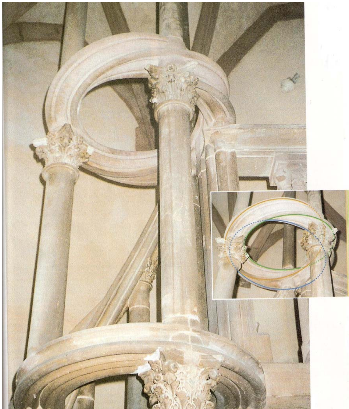
Figure 3 : L'escalier d'accès au musée de l'Œuvre Notre-Dame, à Strasbourg. Le premier palier (en bas) est fait de cercles concentriques (parallèles du tore). Le deuxième palier (en haut) est plus intéressant. Tout d'abord, comme l'autre, il est horizontal, contrairement à ce qu'un effet de perspective de cette photo prise par en-dessous peut laisser croire (on s'en convaincra en considérant que les colonnes reliant un palier à l'autre sont forcément de même taille). Ensuite, il est composé de cercles de Villarceau : à droite, en médaillon, les trois cercles de Villarceau représentés par
